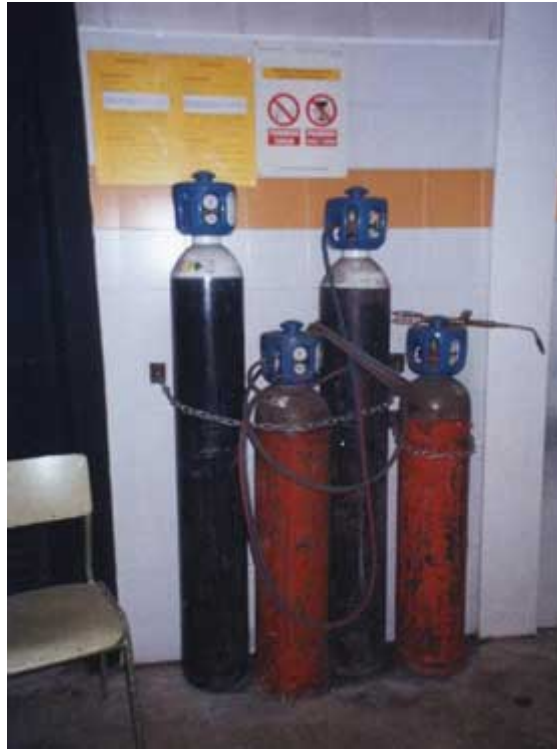
Fig. 3 Equipo de soldadura autógena
