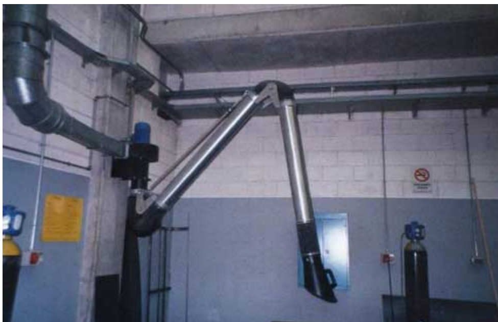
Fig. 2 Boca móvil de aspiración de humos de soldadura
